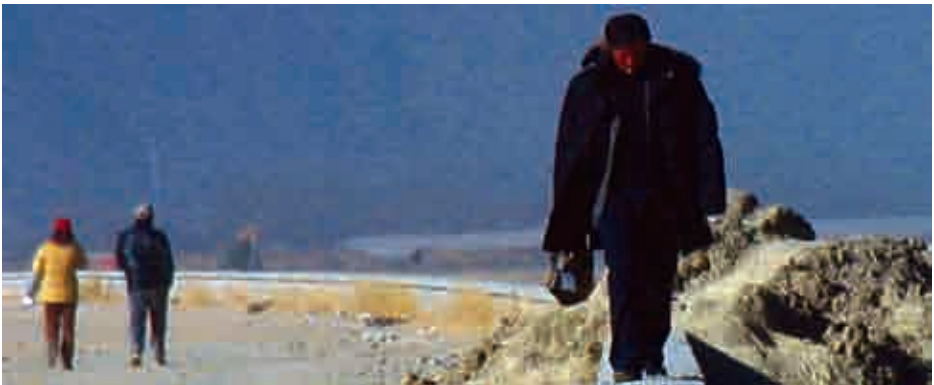
Un Tibétain, tôt le matin, posant les rails du chemin de fer le plus haut du monde, reliant la Chine et le Tibet. La plupart des ouvriers du rail étaient Chinois, les Tibétains se limitant généralement au travail généralement non qualifié. Photo: ICT
